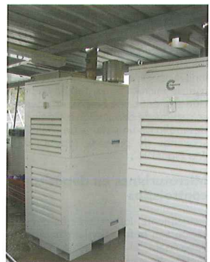
Figura 3. Microturbinas instaladas en el vertedero de Orís
