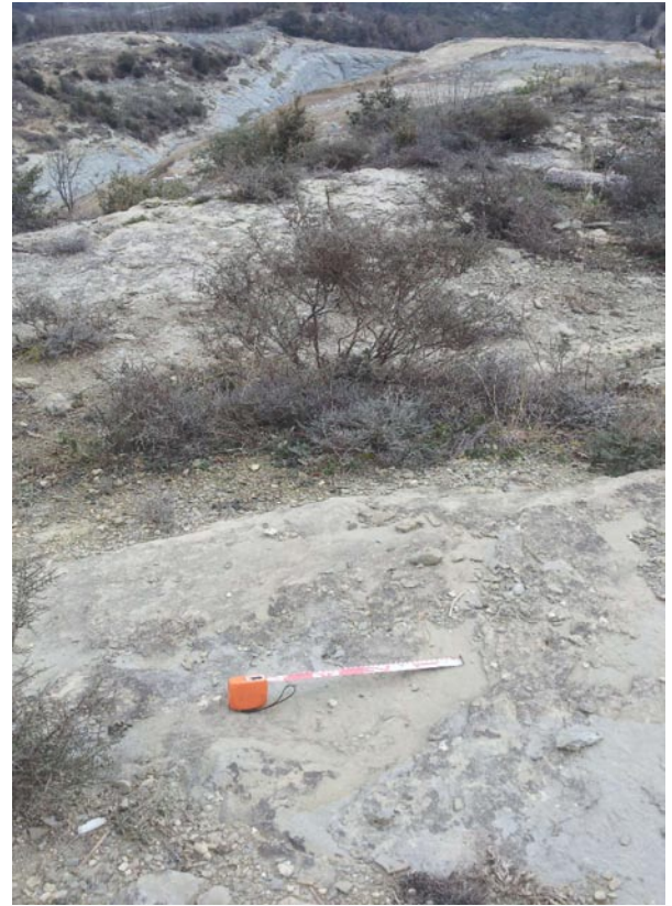
F24. Detall de la unitat B (Roca). Estació geomecànica E-2
