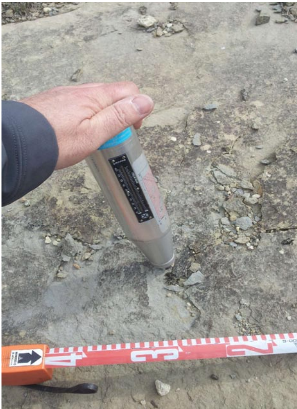
F25. Assaig in situ de resistència a la compressió simple amb escleròmetre. Estació E-2
