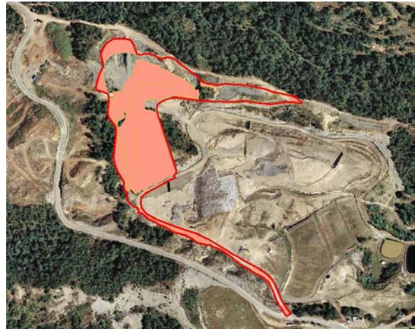
Imatge M4: Desmunt Fase 3.2
