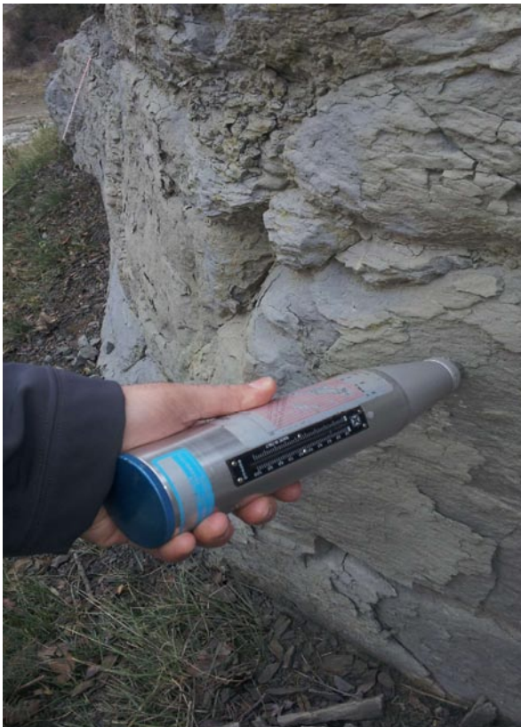
F21 Assaig in situ de resistència a la compressió simple amb escleròmetre. Estació E-1
