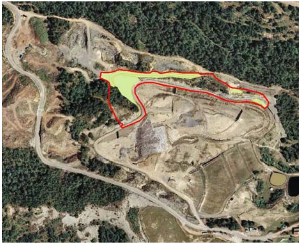
Imatge M5: Terraplè Fase 3.1
