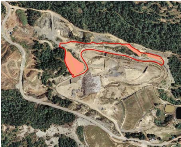
Imatge M3: Desmunt Fase 3.1
