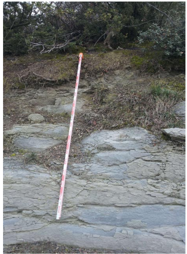
F20. Detall de la unitat A a sobre i unitat B (Roca) a la base. Estació geomecànica E-1
