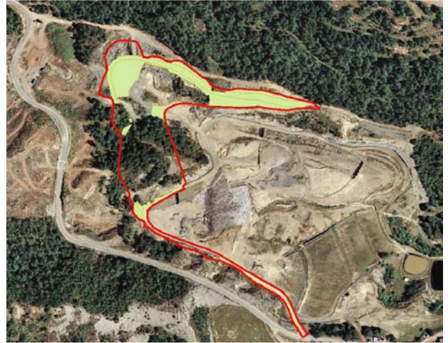
Imatge M6: Terraplè Fase 3.2
